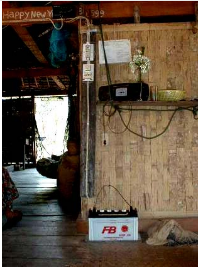
ໝໍໄຟຕໍ່ເຂົ້າກັບເບກເກີ້ ແລະເຄື່ອງໃຊ້ໄຟຟ້າ
